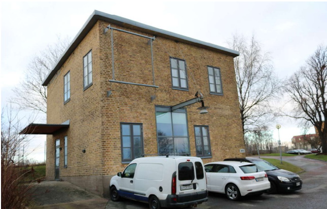
Ostfasaden med större fönsterparti och spår efter äldre skyltning.
