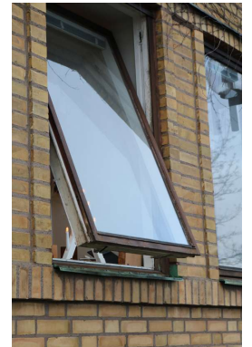
Detalj av vridfönster.
