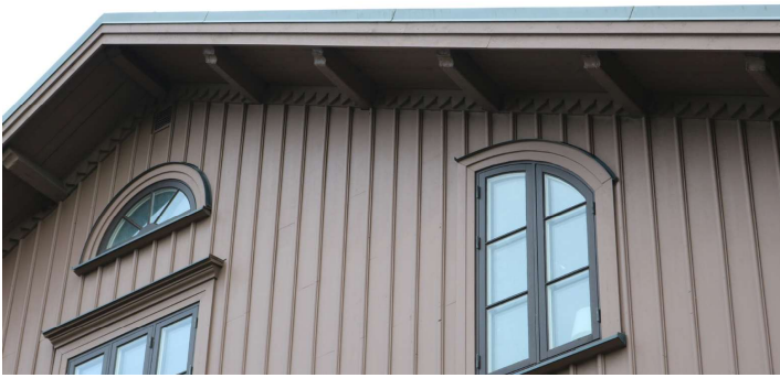
Lunettfönster och fönster med karaktäristisk form finns bland annat under gavlarnas takutsprång.
