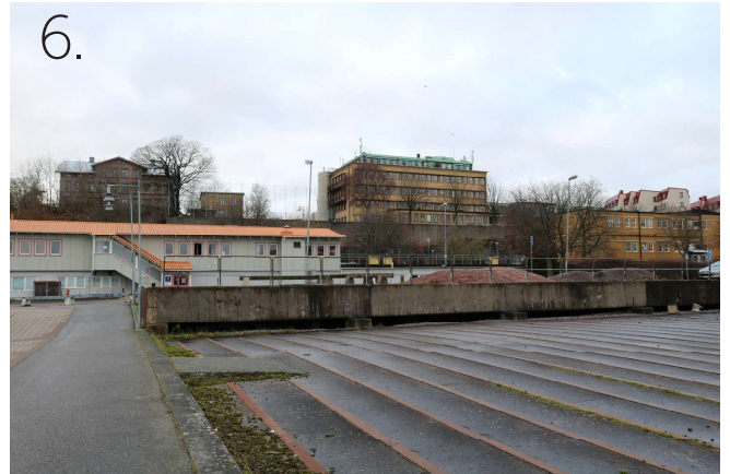
Från parkeringsytorna vid Insiktsgatan ges en tydlig vy över planområdets bebyggelse i en varvshistorisk kontext, där spår efter stapelbäddar m.m. starkt bidrar till det historiska djupet.
