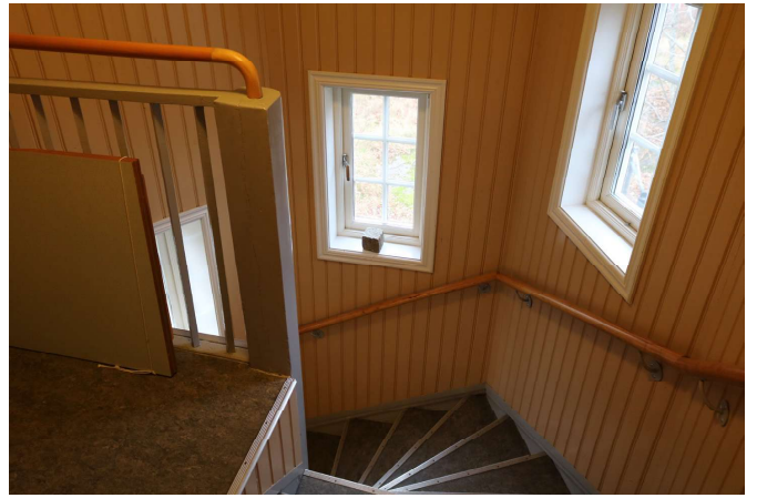
Trapphus sett från vindspan.
