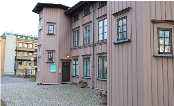
Västfasaden med dess utanpåliggande trapphusbyggnader och stenläggning.
