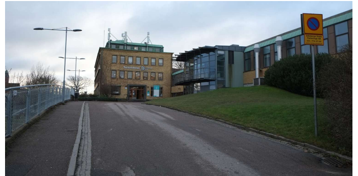
Varvskontorets norra fasad med entréparti möter området mot Plejadgatan.
