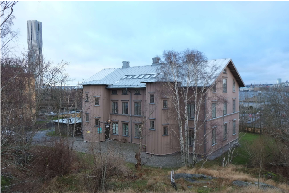
Västfasaden med dess utånåliggande trapphusbyggnader.
