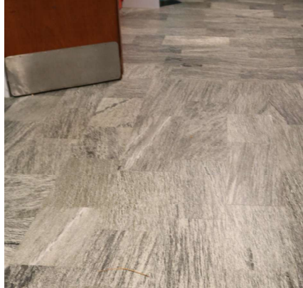
Samtliga allmänna utrymmen har golv belagt med kolmårdsmarmor som bedöms vara ursprungligt.
