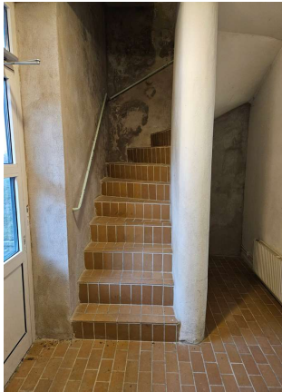
Ursprunglig trappa kompletterad med Höganäsk-linker vid kontorsombyggnaden.
