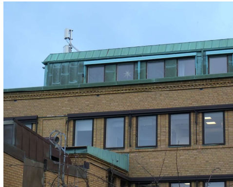
Den översta våningen är indragen och klädd med ärgad kopparplåt.
